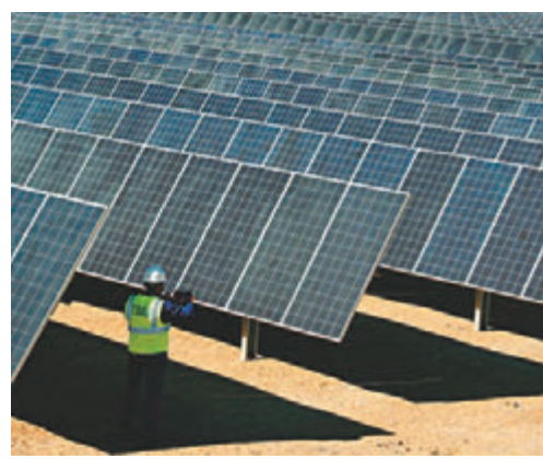
■ 国资委称，央企下一步将着力推进“一带一路”国家及地区的基础设施。图为埃及首个由中国企业承建并参与融资的光伏发电项目。资料图片
