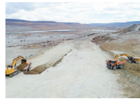
▲施工中的阿根廷孔多克里夫水电站 资料图片
