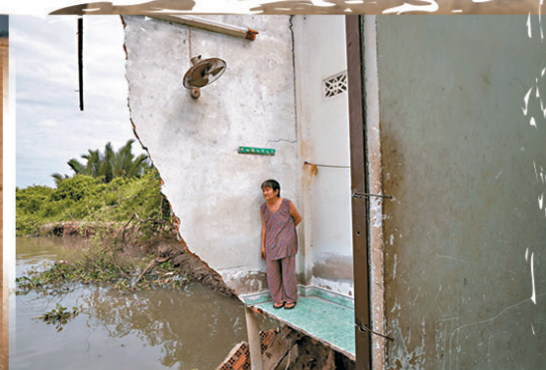
■湄公河三角洲沉降導致沿岸民房倒塌。
