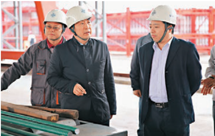
■孟凡超（中）投入於大橋建設工作。
