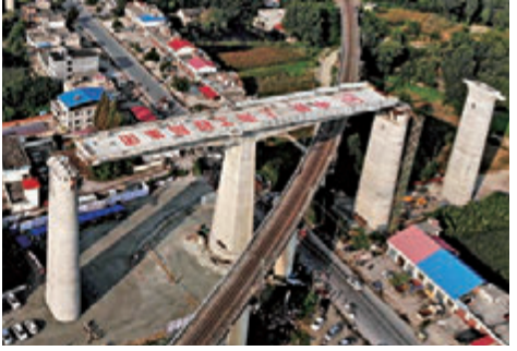
▲蒙华铁路峡河特大桥曲线梁转体成功后续景 新华社
