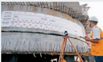
■中鐵上海工程局集團的工作人員在轉體施工現場測量轉體角度。 新華社
