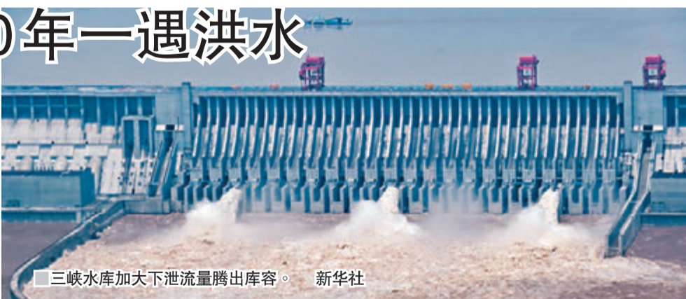
三峡水库加大下泄流量腾出库容。 新华社
