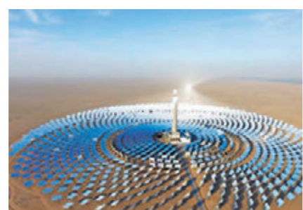
敦煌的太阳能熔盐塔式光热发电站。网上图片
