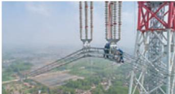
15日上午，位於安徽省無為縣高溝鎮的±1,100千伏古泉長江大跨越架線北岸張力場正在緊張施工(圖)，一排排導線隨着線盤的轉動在人們的監視下逐步向長江南岸的牽引場釋放。隨着西電東送±1100千伏「新疆準東—安徽皖南」特高壓直流工程的最後一相導線順利跨越天塹長江，世界電壓等級最高的特高壓大跨越——昌吉特高壓長江大跨越工程全線貫通。 ■新華社
