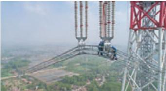
15日上午，位於安徽省無為縣高溝鎮的±1,100千伏吉泉長江大跨越架線北岸張力場正在緊張施工(圖)，一排排導線隨着線盤的轉動在工人們的監視下逐步向長江南岸的牽引場釋放。隨着西電東送±1100千伏「新疆準東—安徽皖南」特高壓直流工程的最後一相導線順利跨越天塹長江，世界電壓等級最高的特高壓大跨越——昌吉特高壓長江大跨越工程全線貫通。 ■新華社
