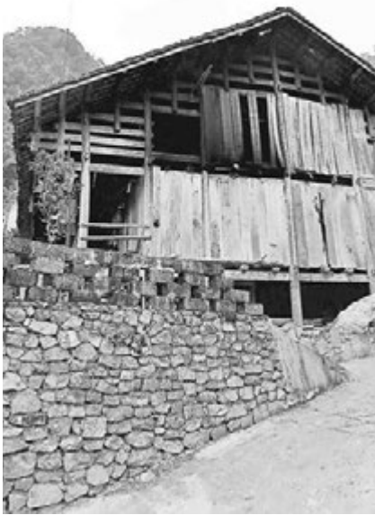
■吳秀文家的老房子成了村裡最後幾座竹木結構干欄式吊腳樓建築。 香港文匯報記者曾萍 攝
