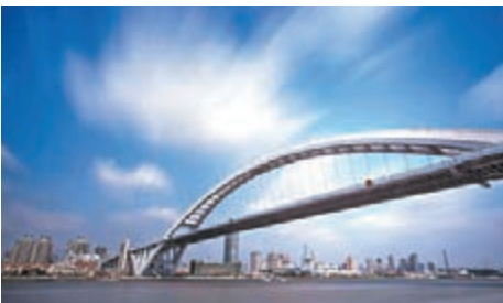
盧浦大橋是上海第二座上榜大橋，設計上融入了斜拉橋、拱橋和懸索橋三種設計工藝，是世界上單座橋樑建造中施工工藝最複雜、用鋼量最多的大橋。
