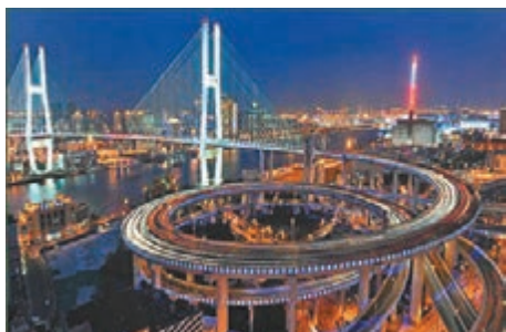
南浦大橋造型剛勁挺拔、簡潔輕盈，景色壯麗。入夜大橋採用中樑照明，主橋用泛光照明，光彩奪目。
