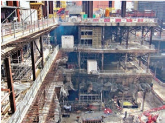
■有消息指，廣深港高鐵香港段將在高鐵西九總站劃出內地口岸區，實施內地法律，進行“一地兩檢”。圖為興建中的西九總站。資料圖片
