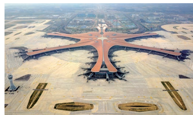
● 中國加快向交通強國邁進，圖為北京大興國際機場航站樓。 新華社
