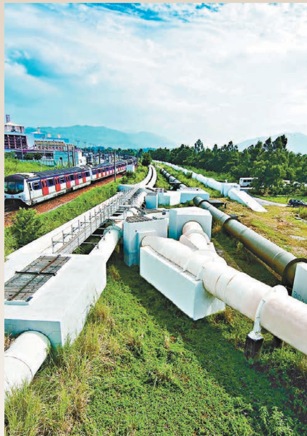
●東江水使香港長期缺水的窘境得到歷史性改變。圖為東江水輸水管。
