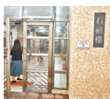
公屋鐵閘漏洞問題再引起關注。
