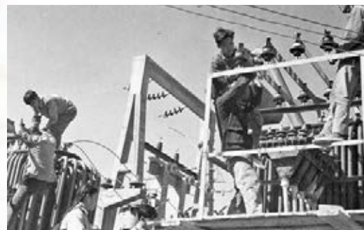
●1964年4月，東深供水工程建設現場。 資料圖片
