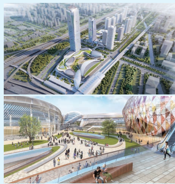
新地於南沙慶盛片區布局大型樞紐綜合項目。項目將分期開發,地基工程現已展開,預計可於2023年起分階段落成
