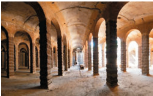
●主教山配水庫
