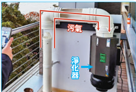
●「虹吸防擾流淨化系統」將排氣喉排出的廢氣淨化過濾，防止擾流效應。
