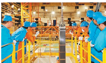
●「華龍一號」福清核電技術人員正在進行首爐接料操作。受訪者供圖
