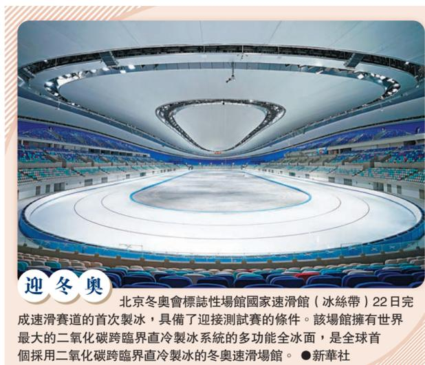
迎冬奧 北京冬奧會標誌性場館國家速滑館(冰絲帶)22日完成速滑賽道的首次製冰，具備了迎接測試賽的條件。該場館擁有世界最大的二氧化碳跨臨界直冷製冰系統的多功能全冰面，是全球首個採用二氧化碳跨臨界直冷製冰的冬奧速滑場館。●新華社
