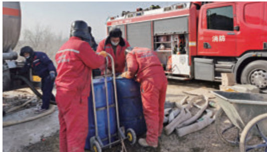
●救援人員正在嚴寒中爭分奪秒地施工。香港文匯報記者殷江宏攝
