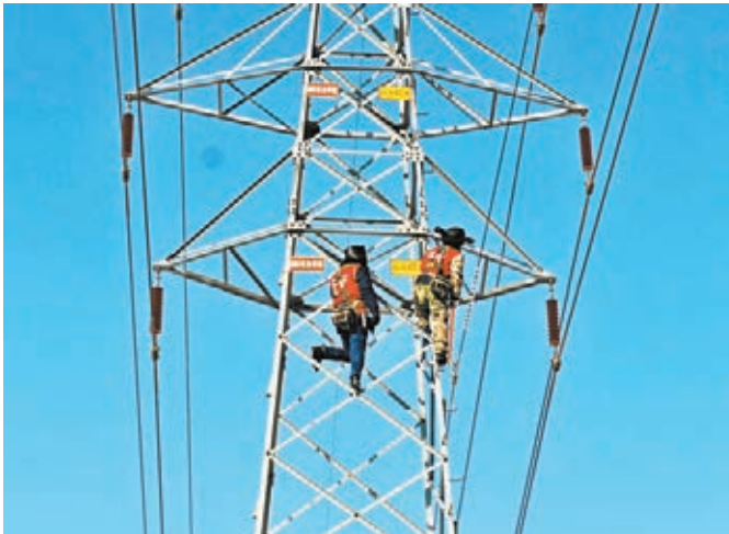
●國務院常務會議強調，務必對民生用氣用電用煤切實做好保障。圖為7日，吉林省強降溫，電力工人搶修供電線路。 中新社
