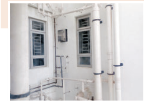
●廚房對出公喉用作固定喉管的「喉碼」已出現明顯生銹的跡象。
