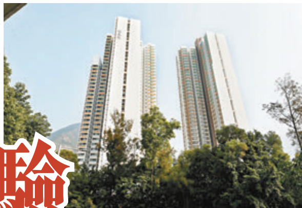
▲是次驗樓單位為最近東涌新居屋剛收樓不久的裕泰苑。
