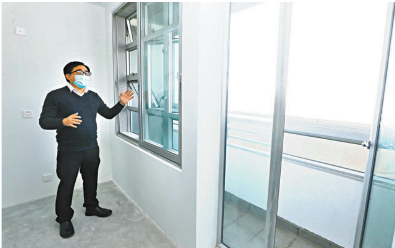
▲賴達明指，居屋單位附設露台的作法少見，不過相信因噪音問題及建築標準等因素，所以露台及單位的窗戶裝上了吸音板及隔音窗。
