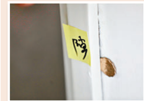
●大廳大門的門框沒有做好「收口」，空隙大小可卡一個「2蚊銀」。
