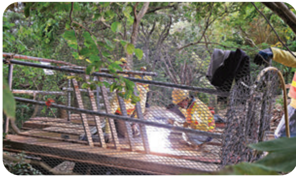
●水務署昨日展開位於主教山的深水埗食水減壓缸臨時加固和整理工程，讓工作人員可以在安全情況下入內視察，以進行復修和保育工作。
