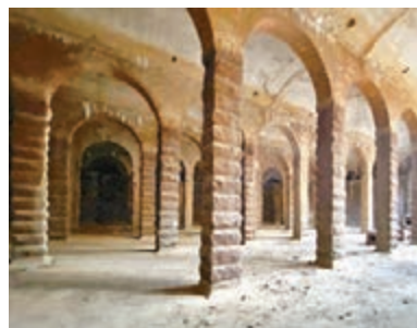
主教山配水庫估計有百年歷史的巨型圓拱門蓄水池。
