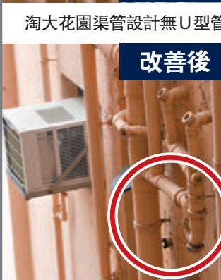
淘大花園在污水管接駁至主糞渠前加裝了總U型隔氣管及反虹吸管
