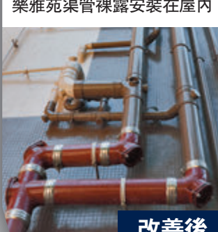
樂雅苑渠管由內牆搬至外牆，單管改為雙管，鹹水管也一同搬至外牆
