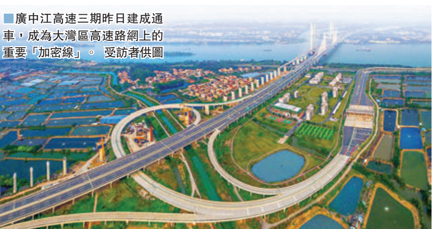
廣中江高速三期昨日建成通車,成為大灣區高速路網上的重要「加密線」。受訪者供圖
