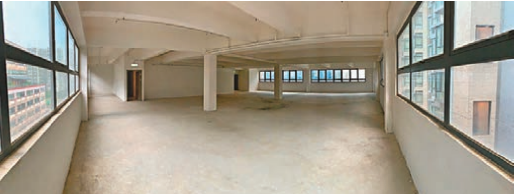
■擬改建為過渡性房屋的工廈內部一隅。
