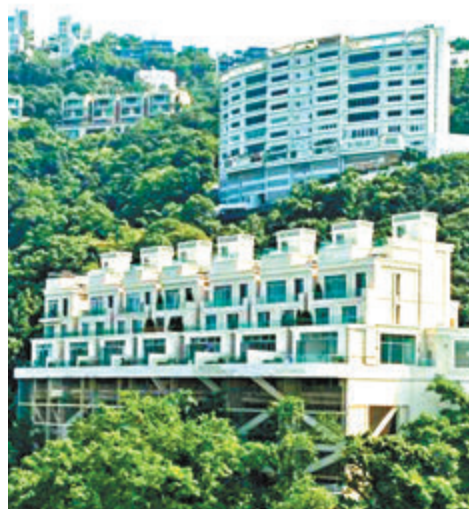
山頂白加道28號5號屋業主四度抵押物業，最終要劈價蝕讓離場。
