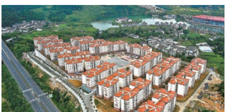
貴州省湄潭縣黃家壩街道田壩社區崇德小區移民安置點。中新社
