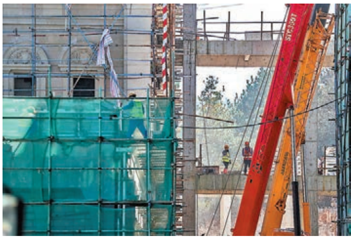
■ 基建投資在不同地區政策及專項債落地等支持下錄得了良好的改善。圖為貴安新區「華為雲」數據中心項目現場施工。新華社
