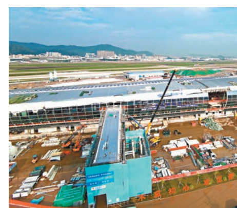
深圳機場衛星廳鋼結構封頂。
