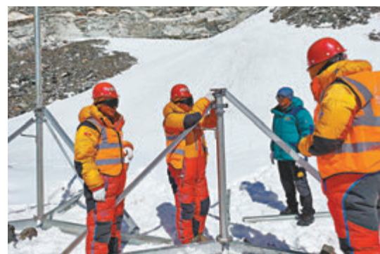
■「十三五」期間，5G商用邁出堅實步伐，目前，已累計開通5G基站69萬個，連接用戶數超過1.6億。圖為早前中國移動工作人員在海拔6,500米珠峰前進營地附近架設5G基站。資料圖片
