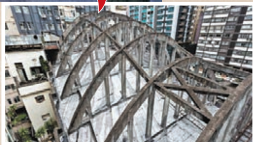
皇都戲院的天台桁架是其標記，曾獲國際保育組織稱為全球獨一無二的建築設計。新世界團隊將力保整個皇都戲院建築及天台桁架。左為效果圖。
