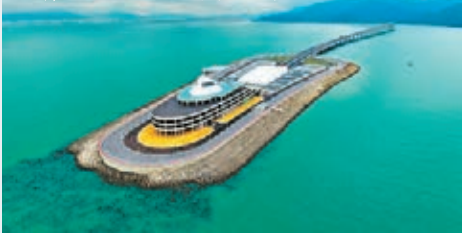
港珠澳大橋推進東人工島旅遊開發。資料圖片
