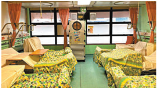
■機電署助把普通病房改建為第二線隔離病房。
