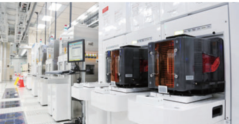
■合肥新站區晶合晶圓生產車間。
