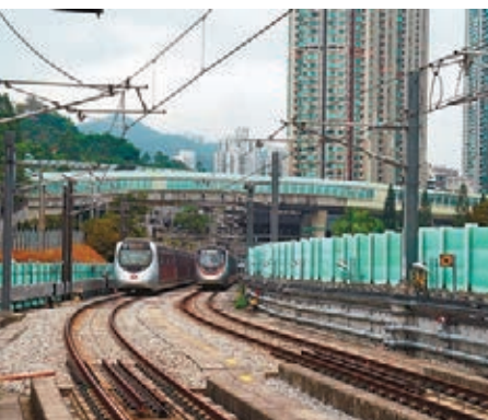
■屯馬綫一期鐵路隧道沉降逾20毫米，啓德地盤暫停施工。 資料圖片
