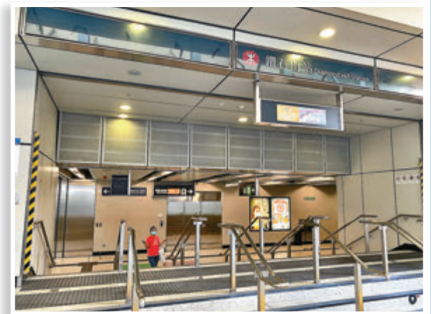
■屋苑位於鑽石山站上蓋,未來接駁沙中線,坐擁雙鐵路優勢,出入相當方便。
