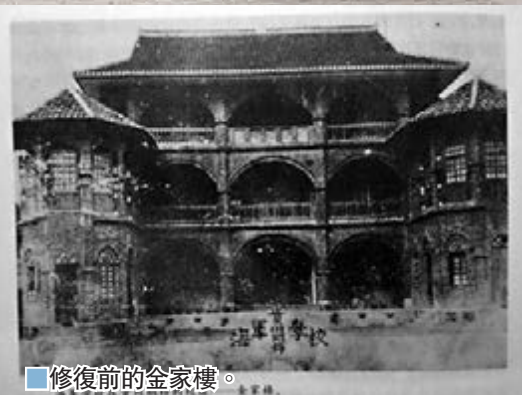
修復前的金家樓。
