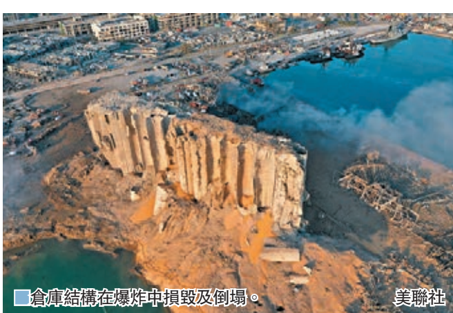
■倉庫結構在爆炸中損毀及倒塌。美聯社
