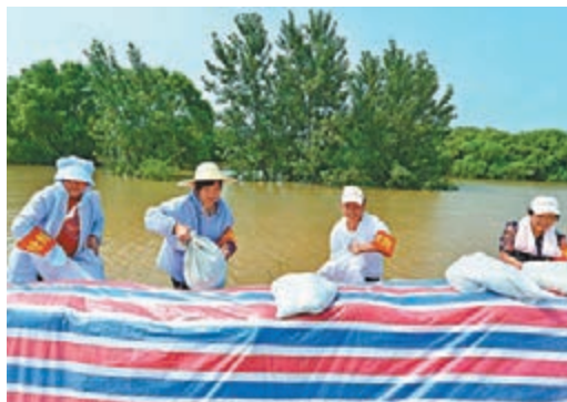
江西九江市江新洲，抗洪「女子突擊隊」正在幫忙加固子堤。
