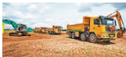
其中一個重點項目——南沙樞紐片區(起步區)基礎配套設施項目開工現場。香港文匯報記者帥誠攝
