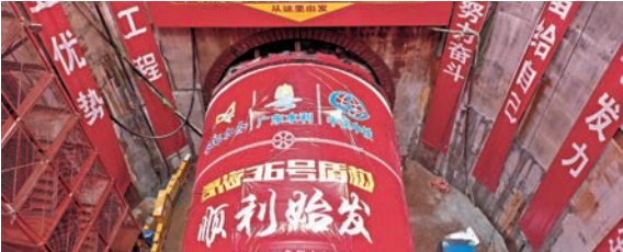
■ 珠三角水資源配置工程首台跨海盾構機成功始發。受訪者供圖
