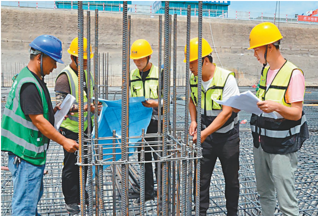
杜剛鋒（右一）在西安的建築工地跟着木工師父學習。
