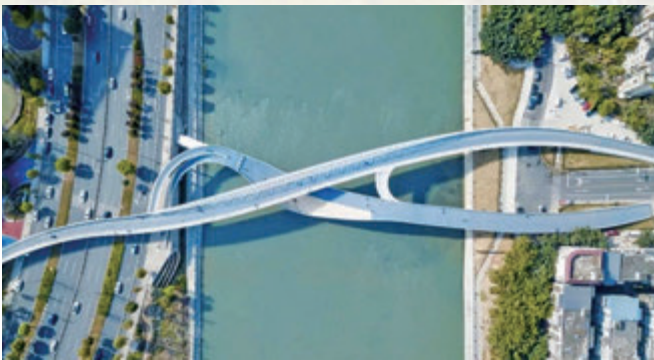
■高空俯瞰五岔子大橋
