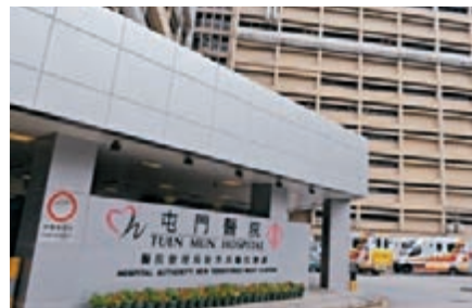
屯門醫院一間隔離病房昨晨因警鐘誤鳴，冷氣及負壓系統停止運作逾一小時。
