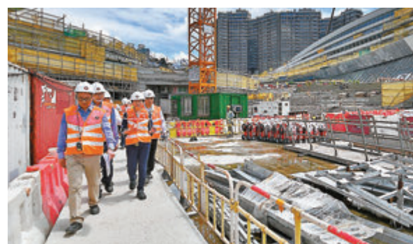
林鄭月娥的fb帖文配上她巡視港鐵建築工地。
